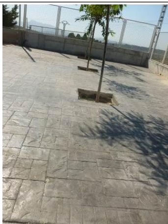
Zona 1 Vaciado de Alcorques
