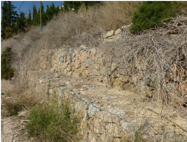
Zona 3 vista de muro de gaviones
