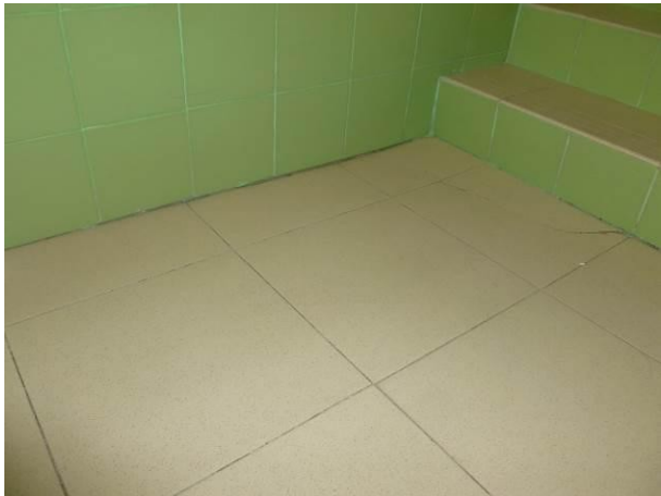
Ala Sur, descuelgue en cajón de escalera
