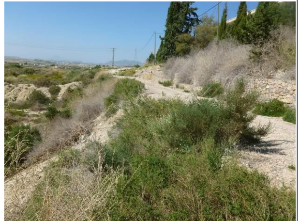
Zona 3 y Zona 5 vista de muro de gaviones y desnivel
