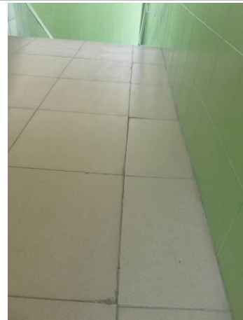
Ala Central, cajón de escalera este
