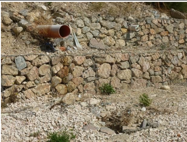
Zona 3 vista de drenaje en muro de gaviones
