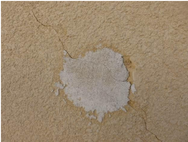
Ala Central, vista de testigo de yeso
