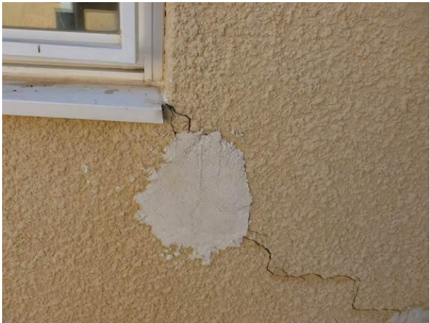
Ala Central, vista de testigo de yeso
