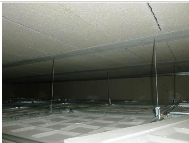
Estructura vista, jácena colgante, forjado unidireccional y vigueta prefabricada
