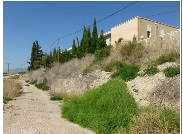
Zona 3 vista de zona sur y muro de gaviones
